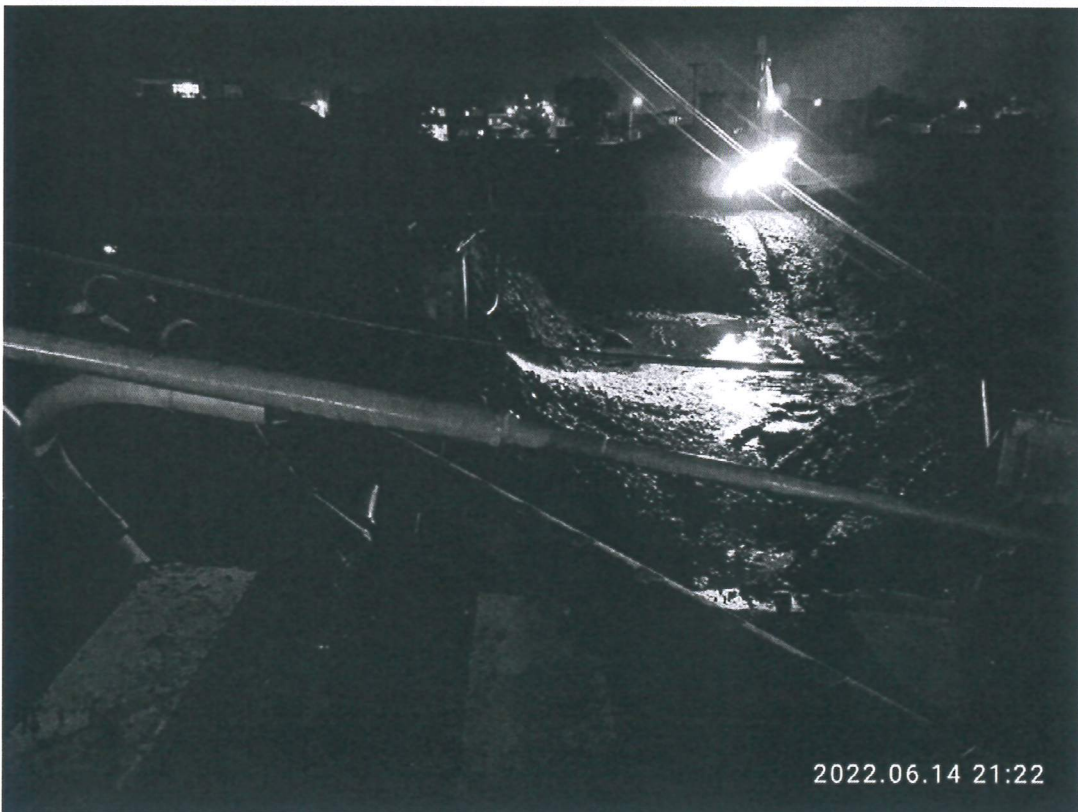
號誌燈基座塌陷垂直滑落
