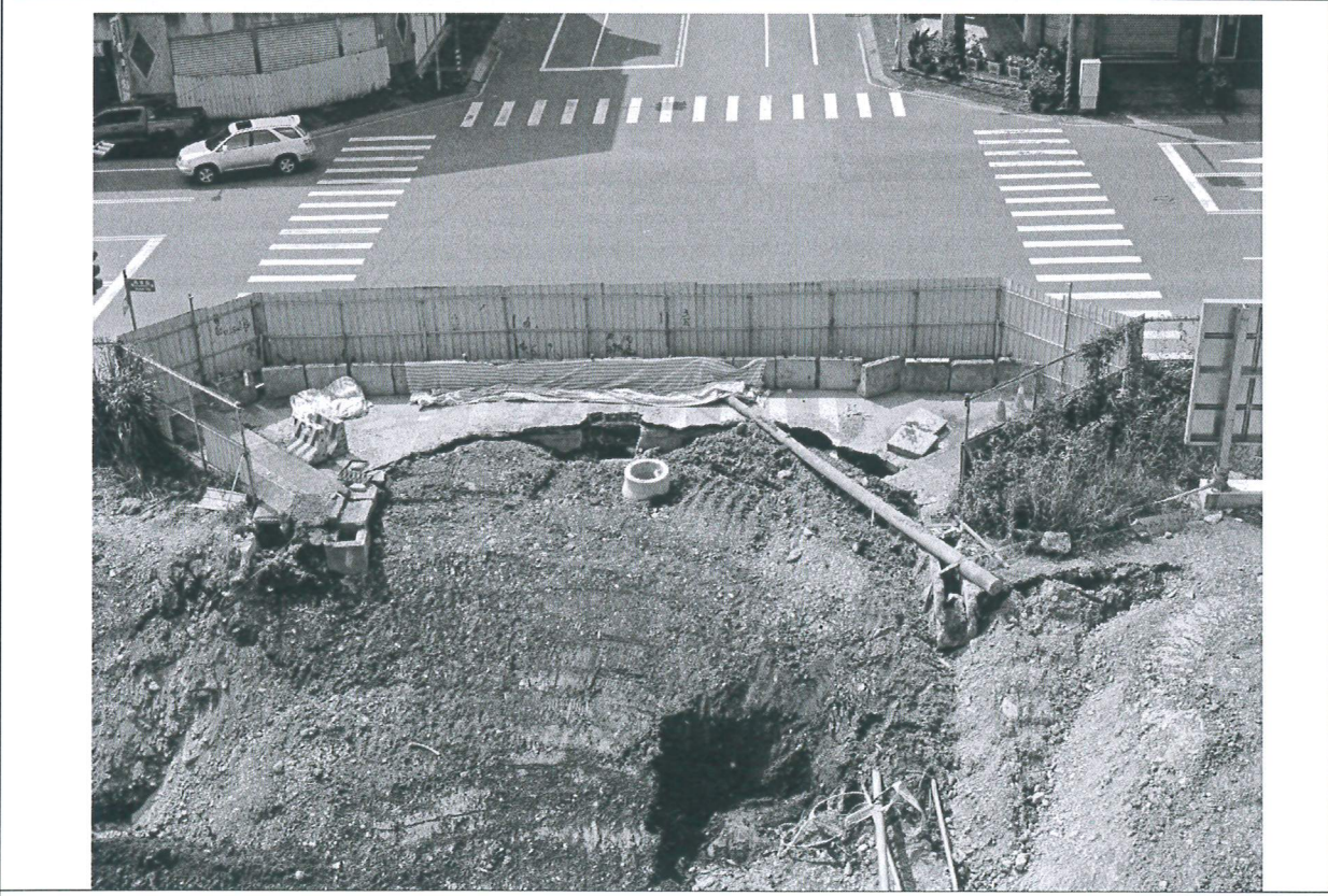
開挖面土石方回填
