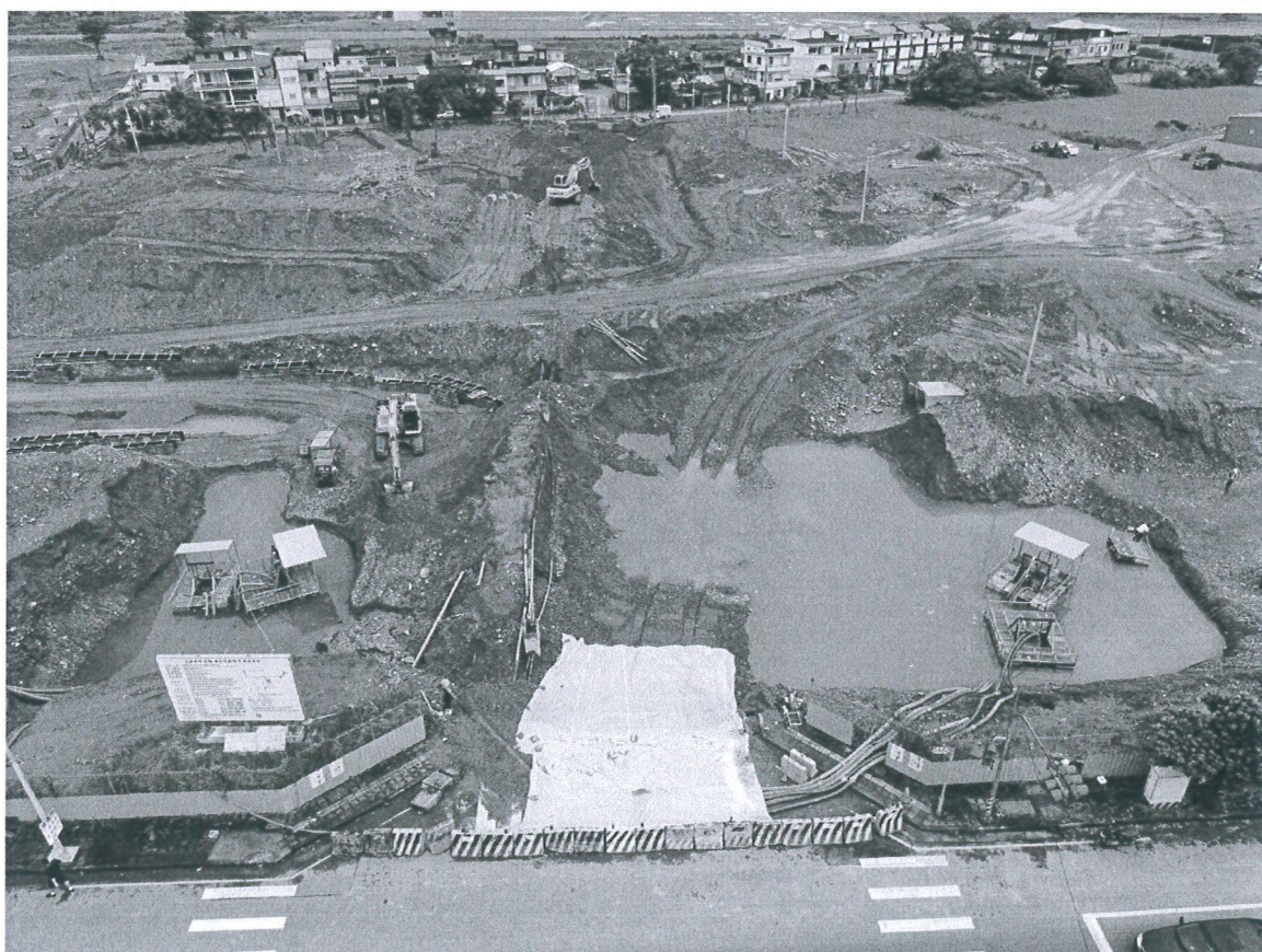
開挖面先行以帆布覆蓋減少雨水沖刷
